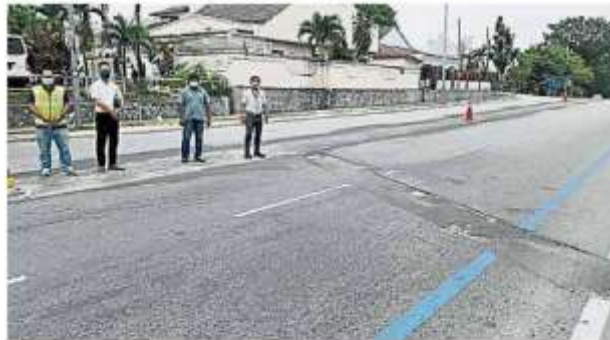
班登柏蘭嶼烏達瑪路進行冷岳2號水站挖掘工程，也有公共設施的挖掘工程在進行。左起是阿來魯、黎維禧、莫根及丘建生。
