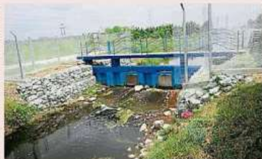
水利灌溉局关闭了挡水闸，以存储足够水源供消防局扑灭旱天林火。
